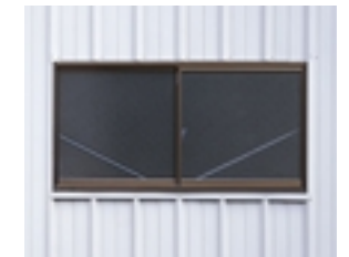
●窓 アルミサッシ サッシ : W1,757×H906mm 網入りガラス 6.8mm 網戸 : W889×H887mm 面格子 : W1,749×H934mm アルミサッシ(小) サッシ W857×H606mm 網入りガラス 6.8mm
